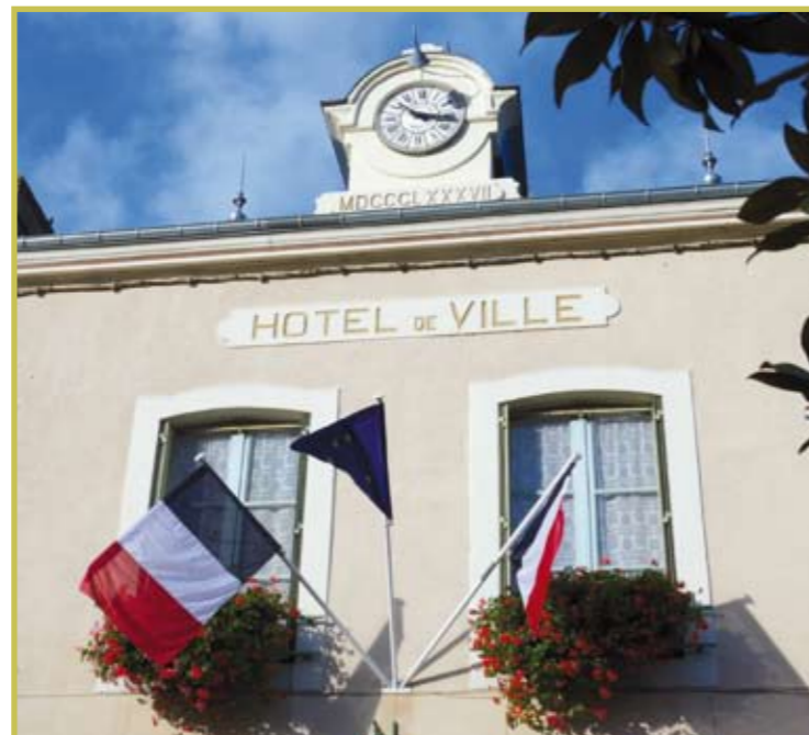
La mairie de Perche-en-Nocé
