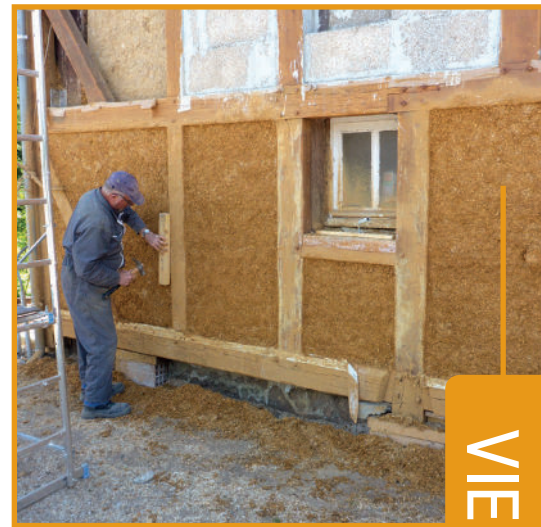
Exemples d'enduits terre-chanvre À gauche, enduit intérieur projeté, ci-dessous banchage, à droite, isolation par l'extérieur qui sera recouverte d'un enduit chaux-sable
