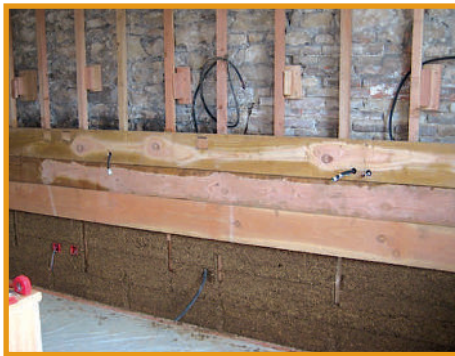
Exemples d'enduits terre-chanvre À gauche, enduit intérieur projeté, ci-dessous banchage, à droite, isolation par l'extérieur qui sera recouverte d'un enduit chaux-sable
