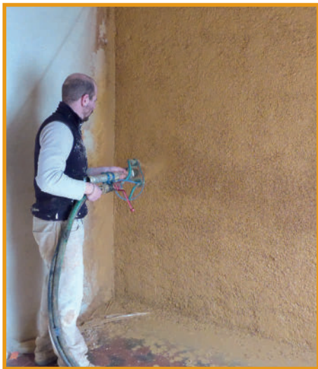
Exemples d'enduits terre-chanvre À gauche, enduit intérieur projeté, ci-dessous banchage, à droite, isolation par l'extérieur qui sera recouverte d'un enduit chaux-sable
