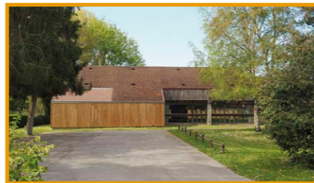
Aménagement du local de la salle des fêtes à Préaux
