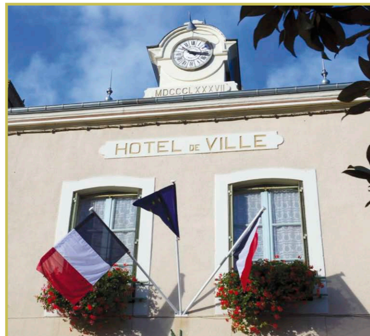
La mairie de Perche-en-Nocé
