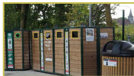
Nouvelle plateforme containers à poubelles à St-Aubin-des-Grois
