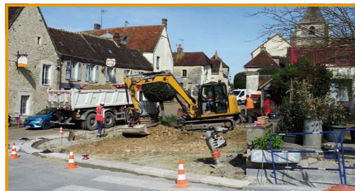
Aménagement du carrefour au centre bourg
