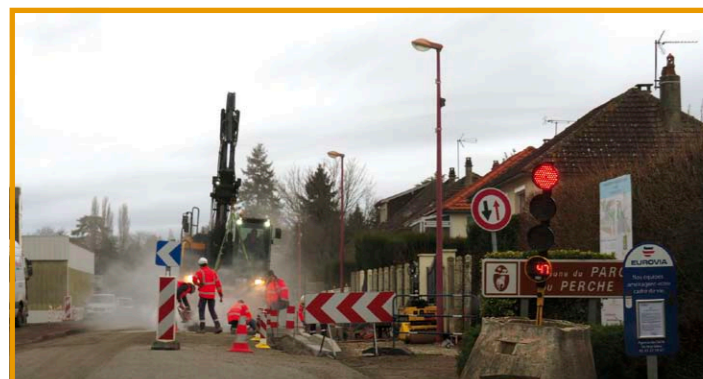
Préparation du chantier rue de l'Ormicolet
