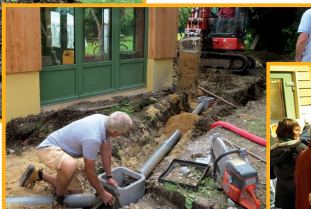
Mise en place de l'écoulement des eaux
